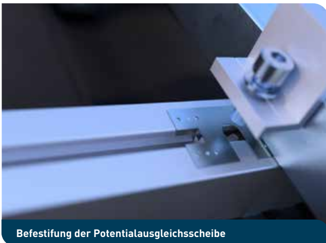
Hinten auf die Modulaufständerung wird der Potentialausgleichclip aufgesetzt und durch die Modulklemme fixiert.
