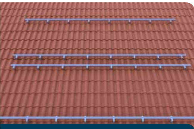
Schritt 2: Nachdem die Dachpfanne wieder geschlossen wurde, wird das Montageprofil Steildach mit der Hammerkopfschraube sowie der Sperrzahnmutter an den Dachhaken befestigt.
