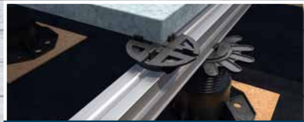
Terrassenbau mit HSI
