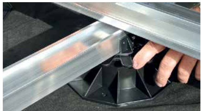
Odkręcić dla uzyskania dokładnej wysokości
