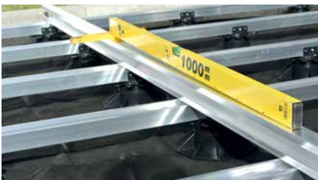
Wyważyć do uzyskania właściwego spadku
